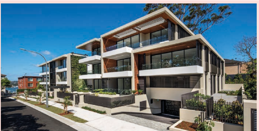
Drummoyne, PCA Architects
